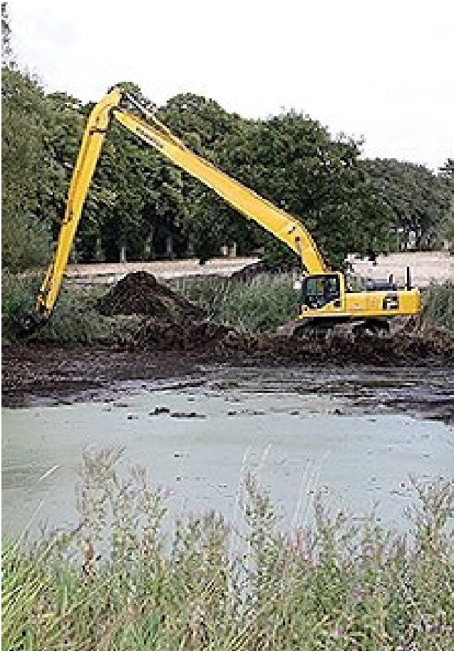
Udgravning af sediment i gadekær - fysiske metoder. Billedet taget fra internet: soe—mose.dk2020
