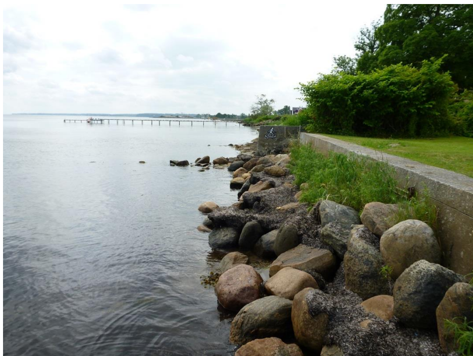
Figur 2.3: Strandlod beskyttet af beton mur med sten foran 167.
