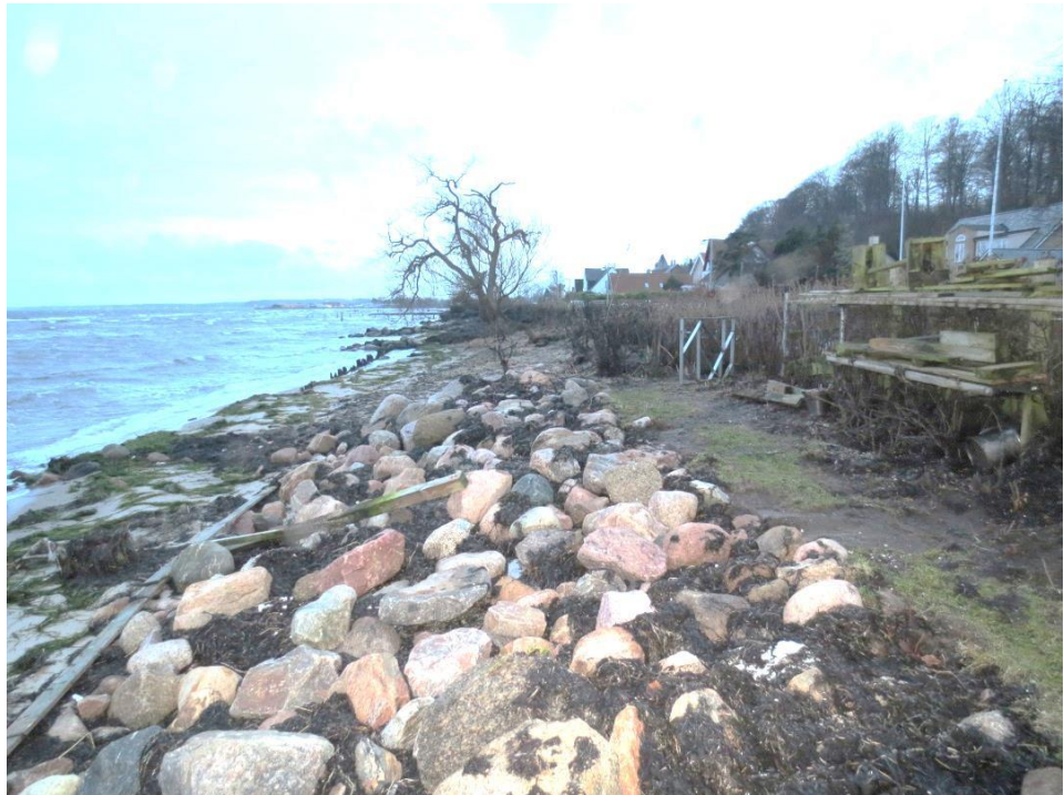
Figur 2.5: Stensætning, der modstod Bodils bølger og sikrede strandloden.
