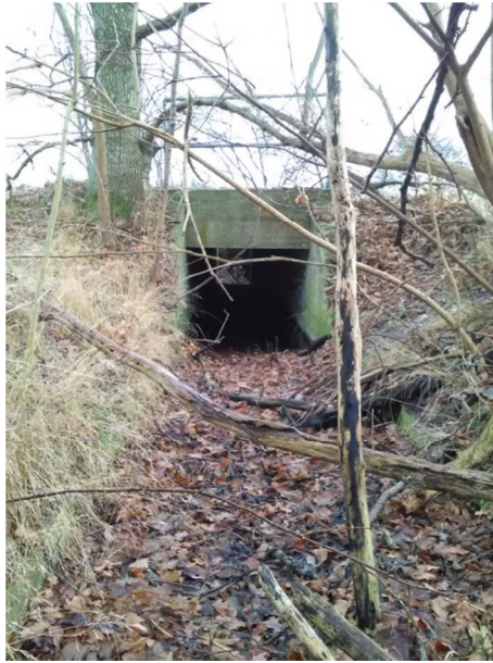
Figur 3-10 Vandløb under Strandvejen ved stationering 1810.
