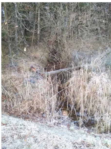
Figur 3-8 Tilløb fra tværgående grøft. Samtidigt ses enden af en rørføring under Strandvejen. Billedet er taget mod vest ved stationering 1220.
