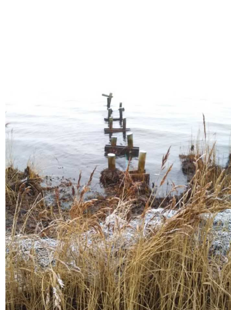
Figur 3-9 Udløb omkring stationering 1350. Udløbet er ca. 300 mm i diameter og fastholdes af en trækonstruktion. Lignende udløb findes omkring stationering 1220, 1400, 1550 og 1670.
