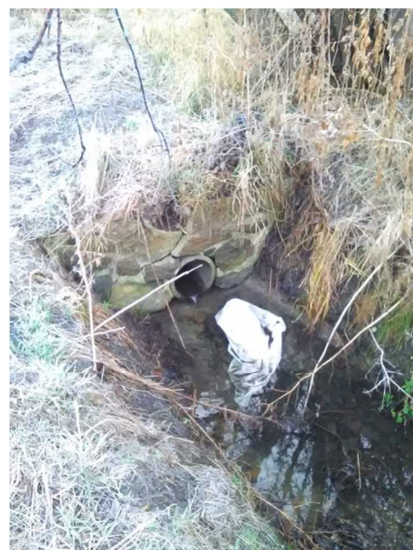
Figur 3-7 Grøften starter med udløb fra et lukket vandløb på 140 mm i diameter.
