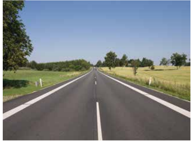
Kig mod nord, syd for Hesselrød tæt ved tilslutningen til Helsingørmotorvejen i Hørsholm.
