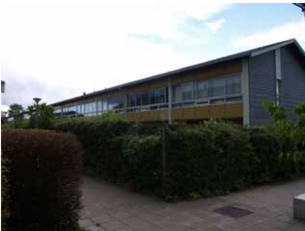
Bolig i den sydlige del af Skovengen.
