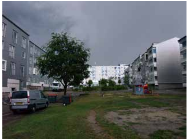
Egedalsvænge i gang med en større fornyelsesproces, hvor hele boligområdet på registreringstidspunktet er under ombygning og facaderenovering.
