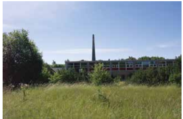
Skorstenen ved Nivaa Ringovn.
