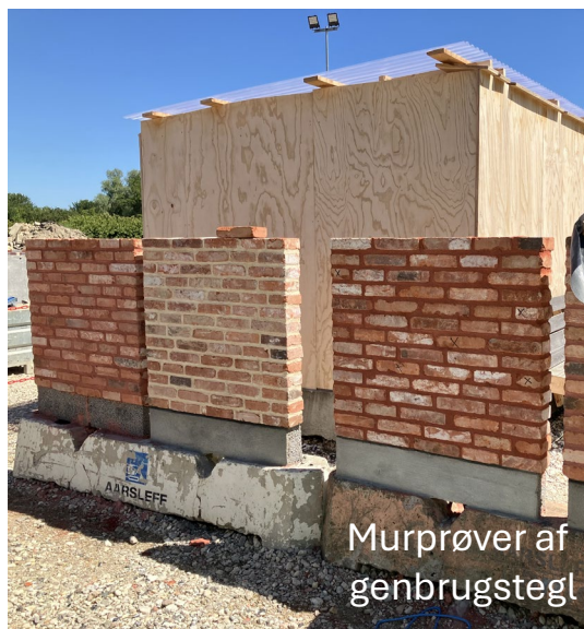
Tegl genanvendes i byggeriet af den nye skole.
