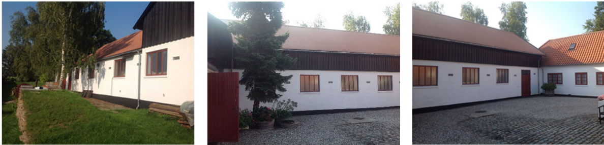
Foto 16 -18 Bygning 2 - Tolængede driftsbygning set mod nordøst, vest og nordvest.
