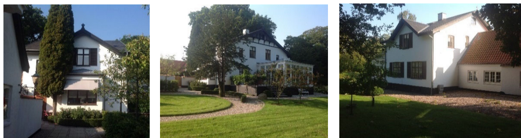
Foto 13 – 15 Bygning 1 - Hovedbygningen set mod nord, vest og sydøst.
