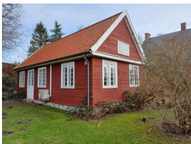
Konfirmandstue opført ca. 1920 med rød malet træbeklædning, originale vinduer og røde tegl på taget.
