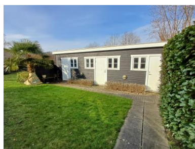
Udhus i skel mod jernbanen. Opført med brædebeklædning, og hvid malet vinduer, som stilmæssigt passer til hovedhuset.
