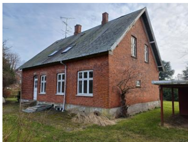
Vest- og sydfacade.
