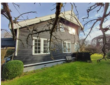
Hovedhuset set fra sydgavl, hvor det asymmetriske tag afslører at huset er i én etage med udnyttet tagetage.
