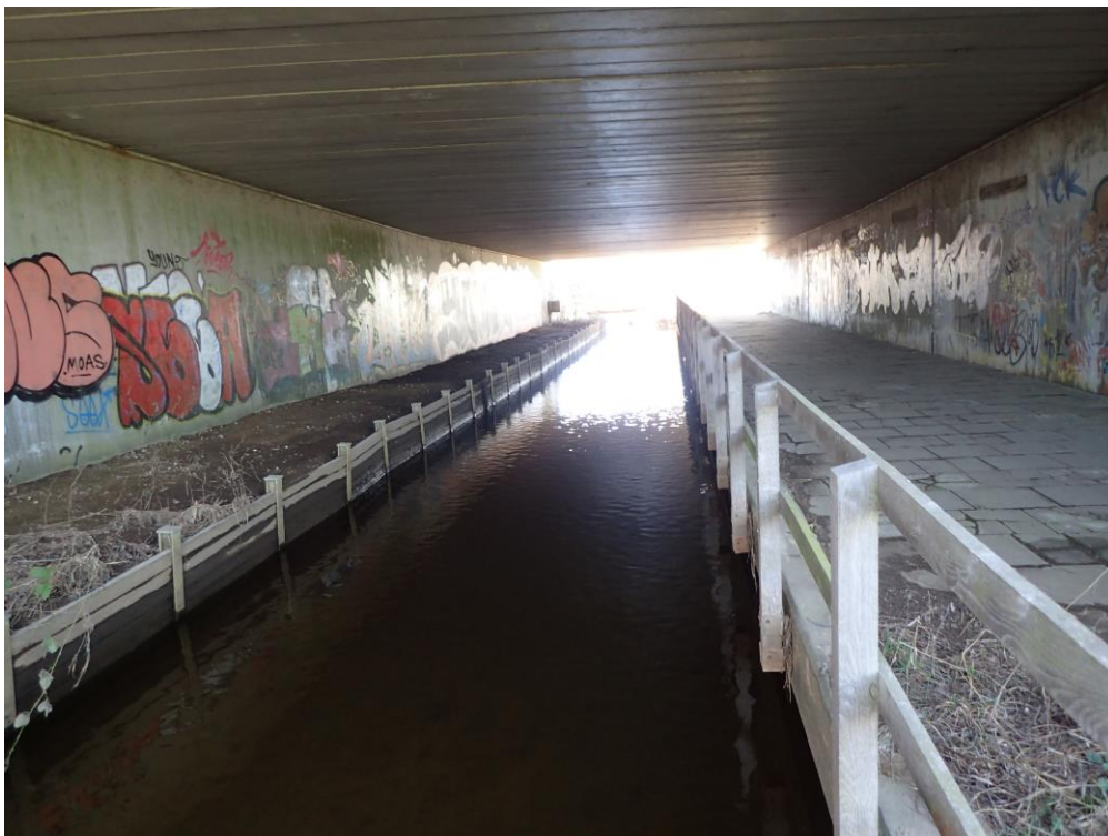
Billede 1: Viser den sydlige (venstre side af billedet) brink af Nivåen, hvor brinken er sat med I-jern og brædder på strækningen mellem vandløbsstationering 4960 - 5010. I-jern og brædder ønskes fjernet og i stedet etableres et skråningsanlæg på 1:1.
