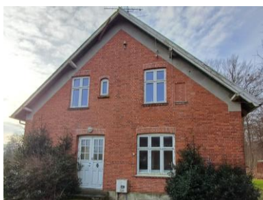
Nordfacaden hvor indgang til ny sognegård skal etableres sammen med tilbygning.
