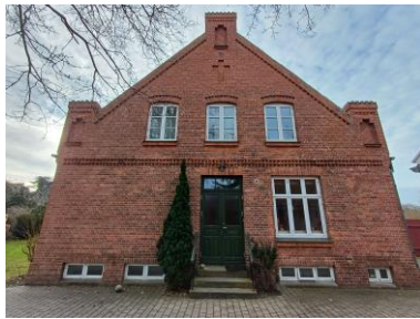
Hovedbygning som danner ramme om præsteboligen har mange fine detaljer i murværket. Øverst f.eks. korstegn motiv.
