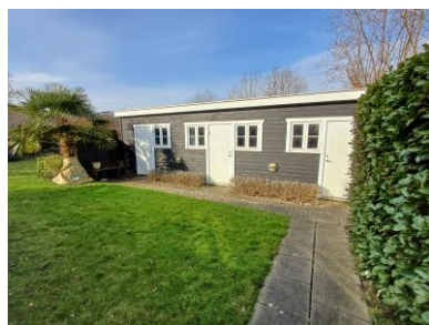
Udhus i skel mod jernbanen. Opført med bræddebeklædning, og hvid malet vinduer, som stilmæssigt passer til hovedhuset.
