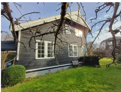
Hovedhuset set fra sydgavl, hvor det asymmetriske tag afslører at huset er i én etage med udnyttet tagetage.
